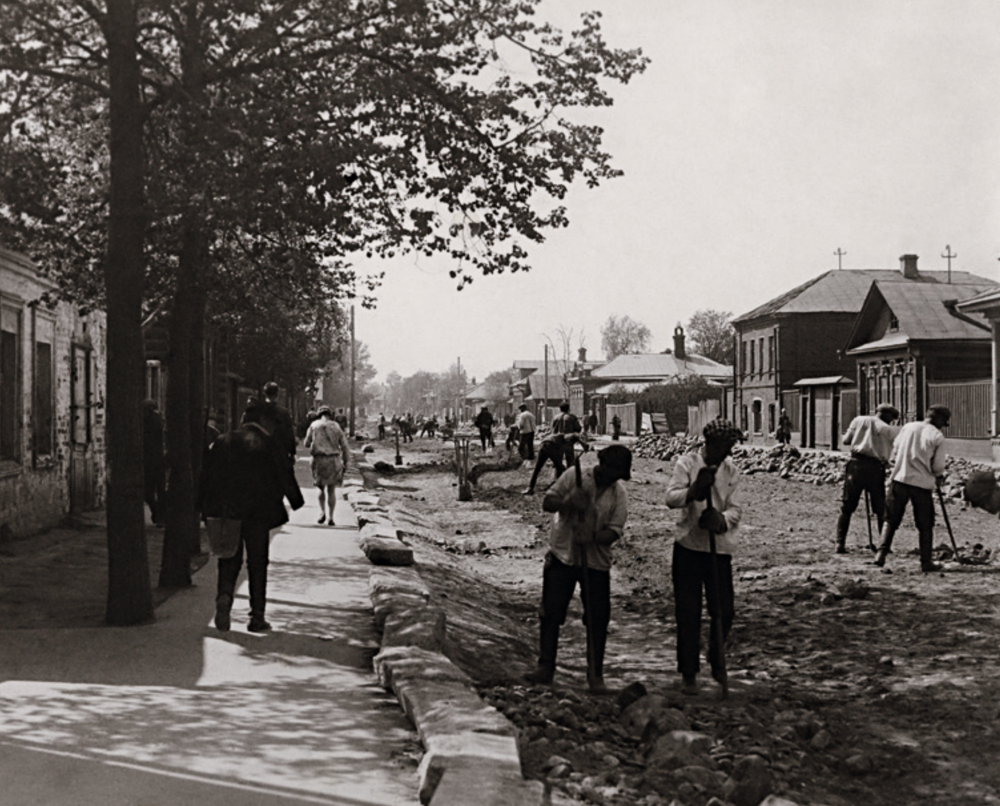
Строительство проезжей части на улице им. К. Маркса. Иваново-Вознесенск, 1932.
